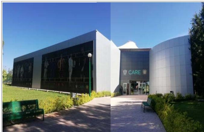
F1: Fachada principal
