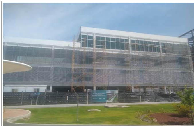
F1: Fachada principal
