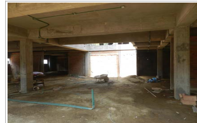
F5: Interior de aula
