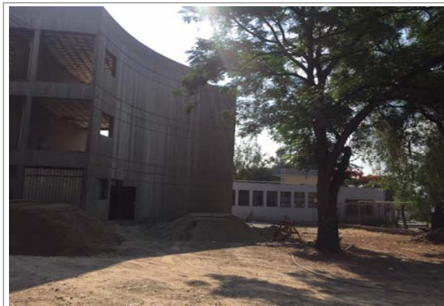
F1: Fachada principal
