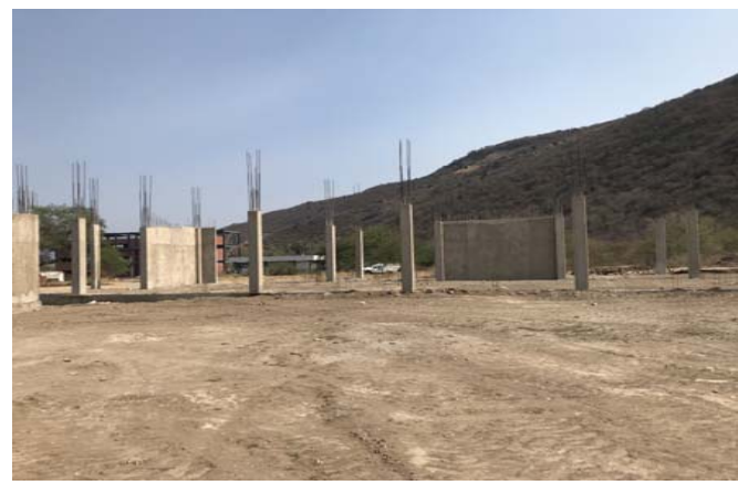
F1: Fachada principal
