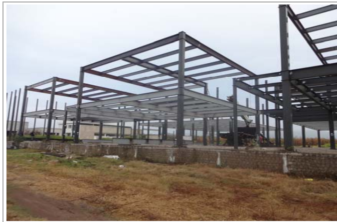
F1: Fachada principal
