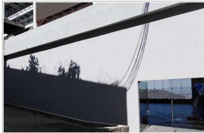
F1: Fachada principal
