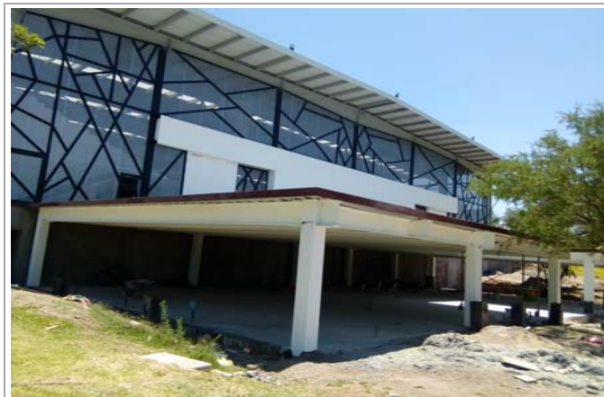
F1: Fachada principal
