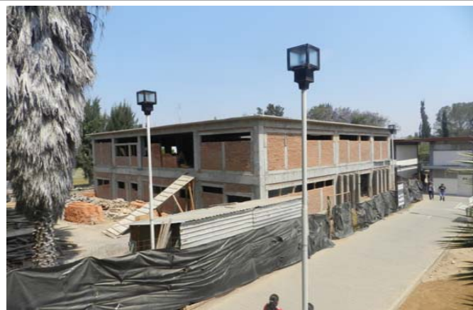
F1: Fachada principal
