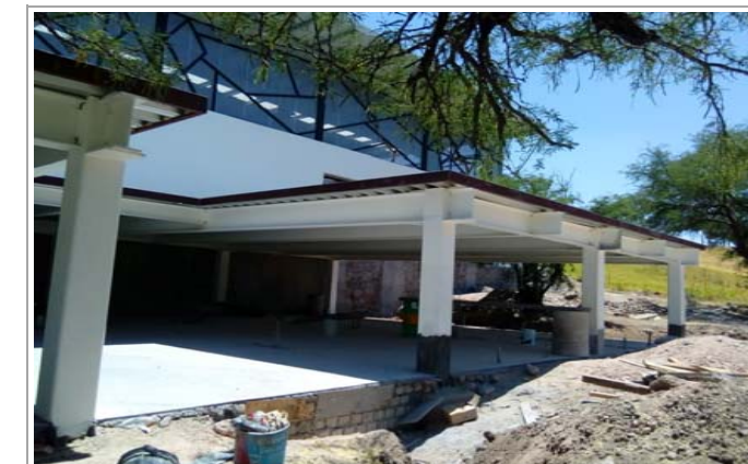
F5: Interior de aula
